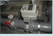
プール還水槽仕切弁 23 (キャパシタ式緊急遮断弁)
