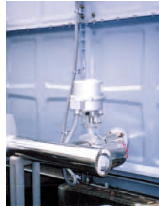
▲受水槽緊急遮断設備
