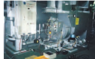
▲受水槽緊急遮断設備
