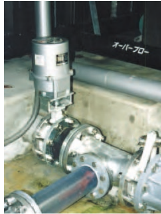
▲受水槽緊急遮断弁
