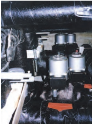
▲大型水族館 濾過給水制御バルブ
