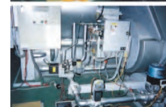
▲ガス吸収式冷温水機
