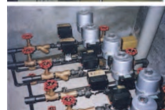
▲大型ビル 空調管理設備
