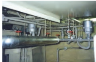
▲受水槽緊急遮断弁
